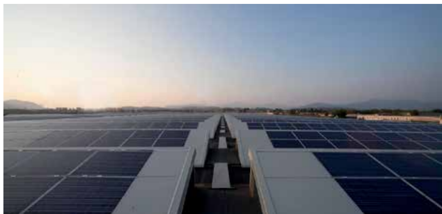
Copertura fotovoltaica dell'azienda
